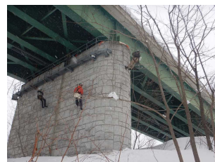
ロープアクセス調査状況
