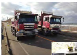
橋梁耐力照査(静的載荷)
